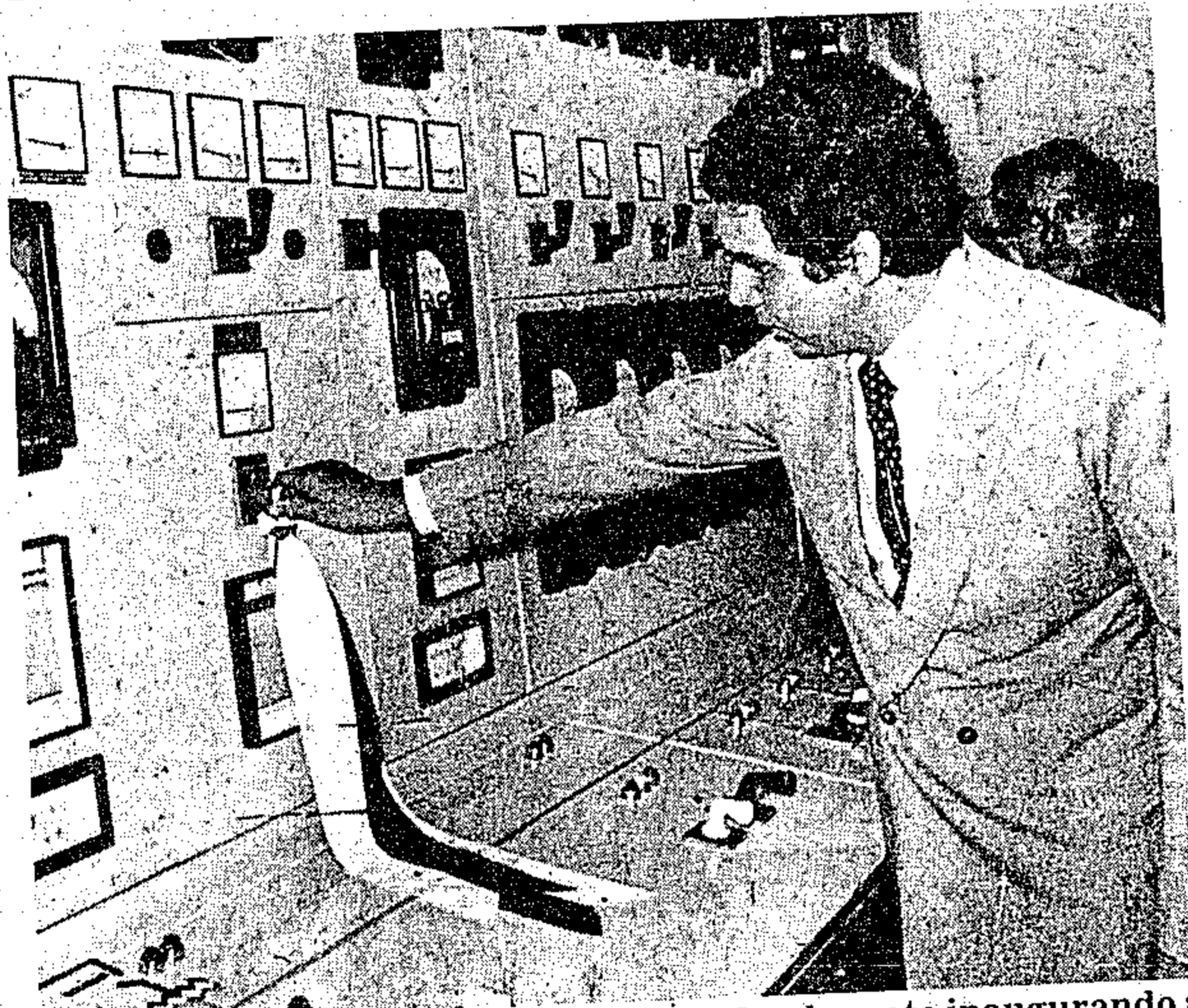
O governador Jader Barbalho acionando a barreta inaugurando a sexta subestação no setor energético.
