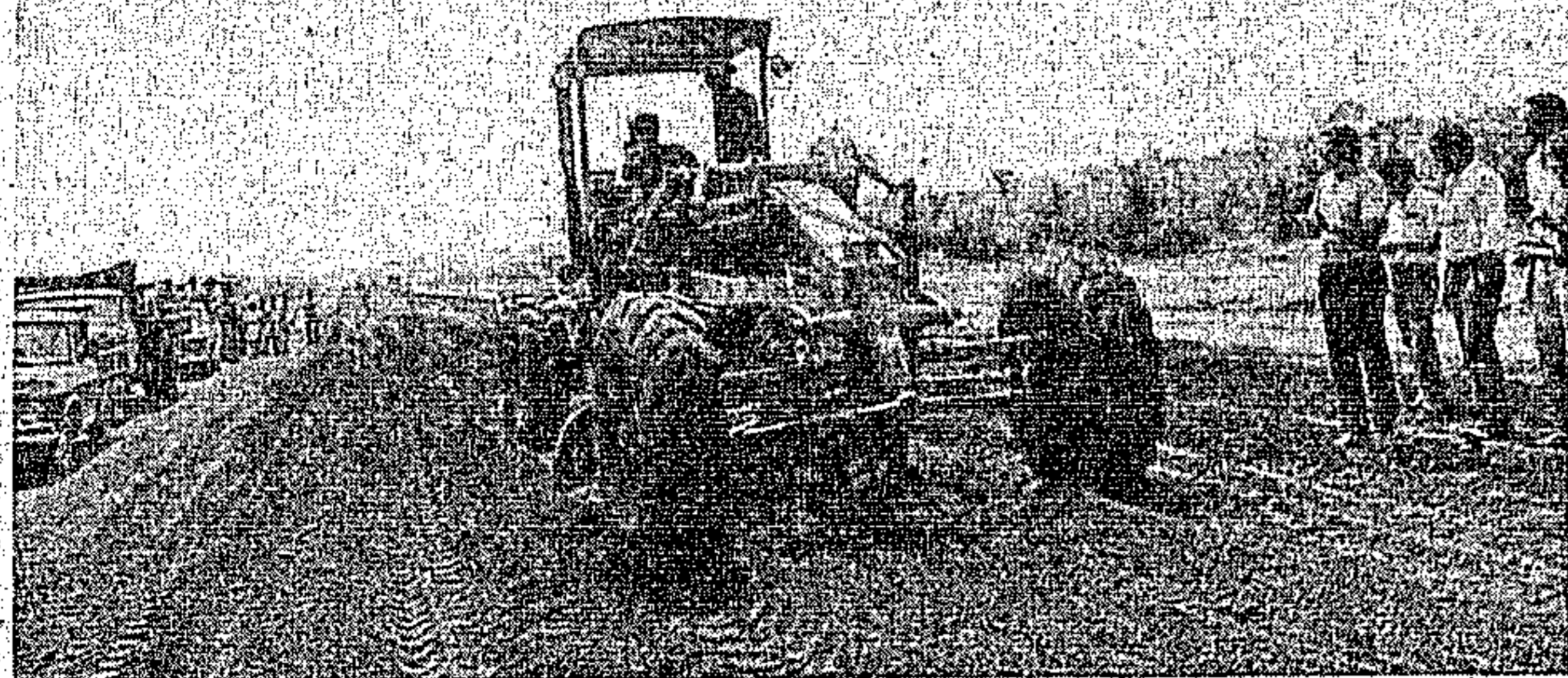
A Rodovia PA-150 é uma das metas prioritárias do Governo Jader Barbalho e tem seus serviços de pavimentação assegurados.
