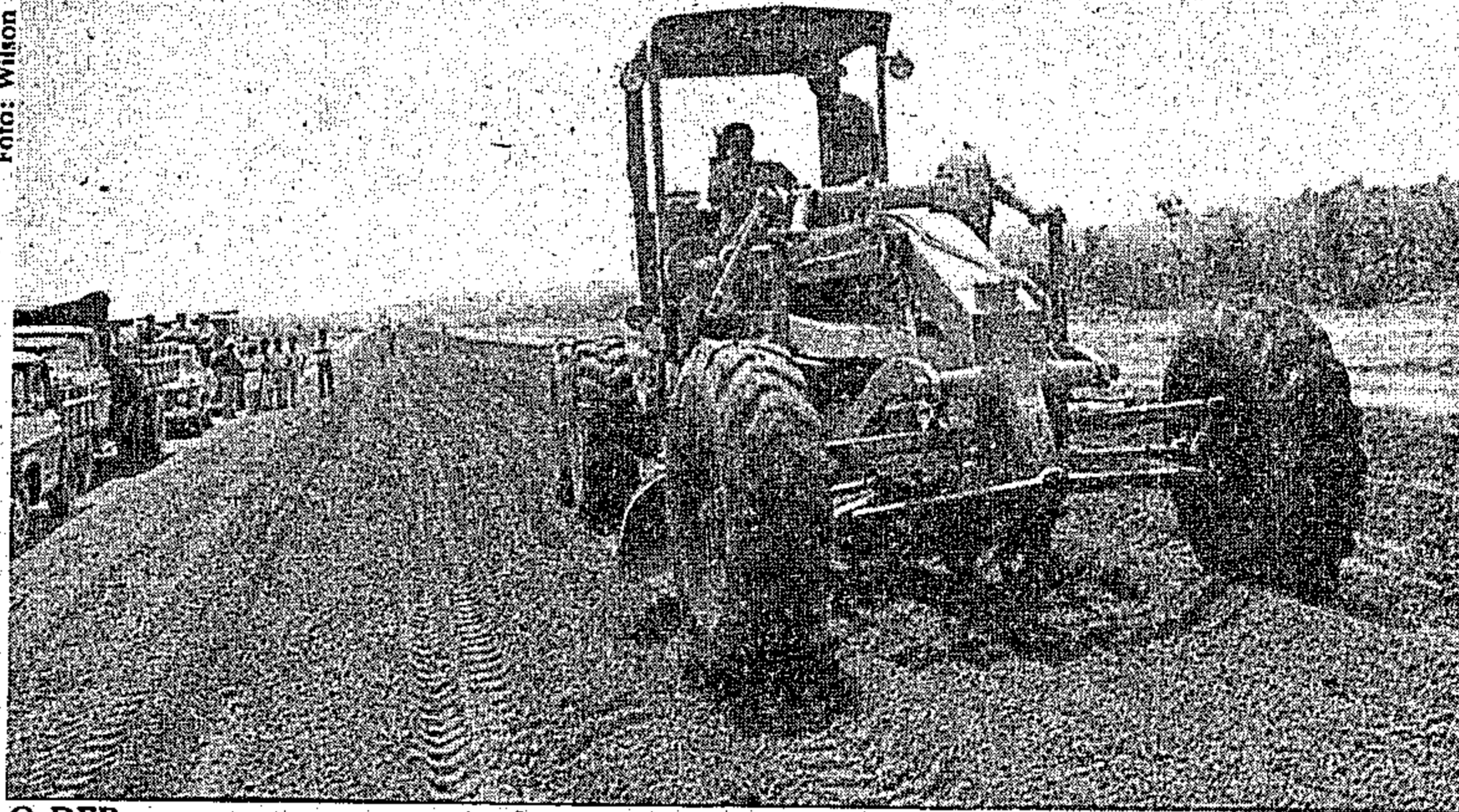
O DER garante a recuperação das estradas em vários pontos do Estado
