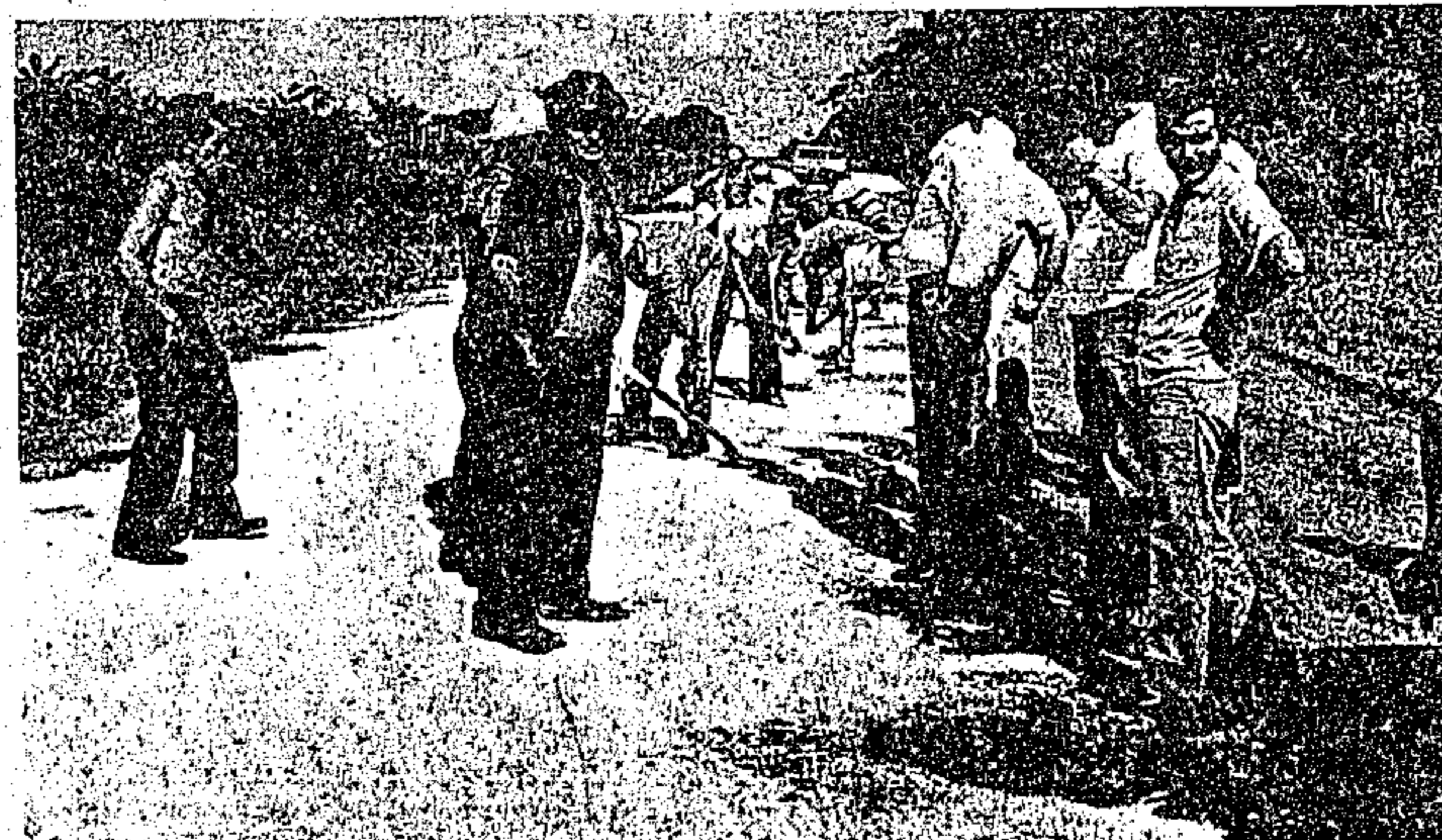
Trecho recuperado da PA-242 (Capanema-Bragança).
