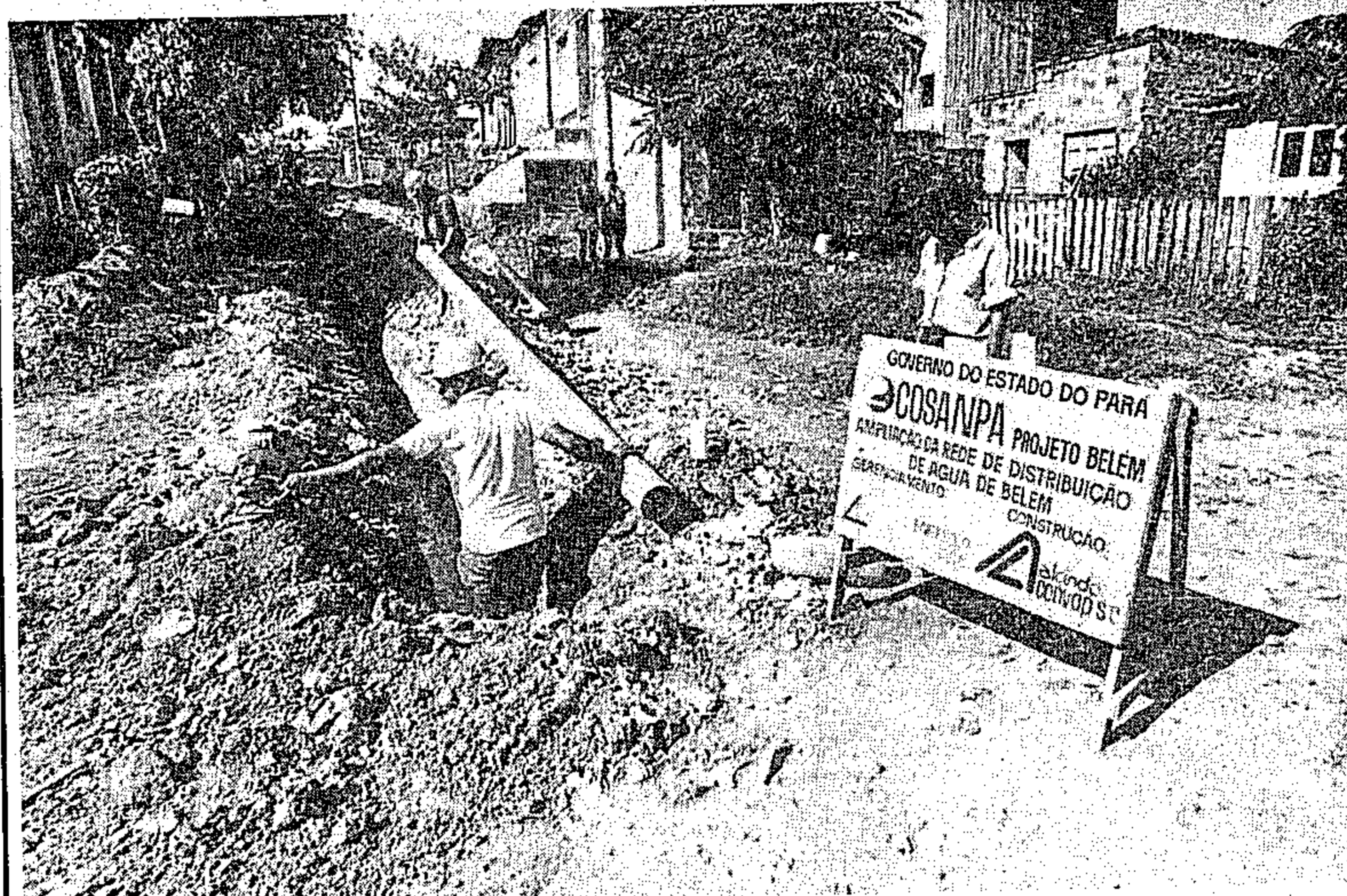
Assentamento de rede na travessa Angustura
