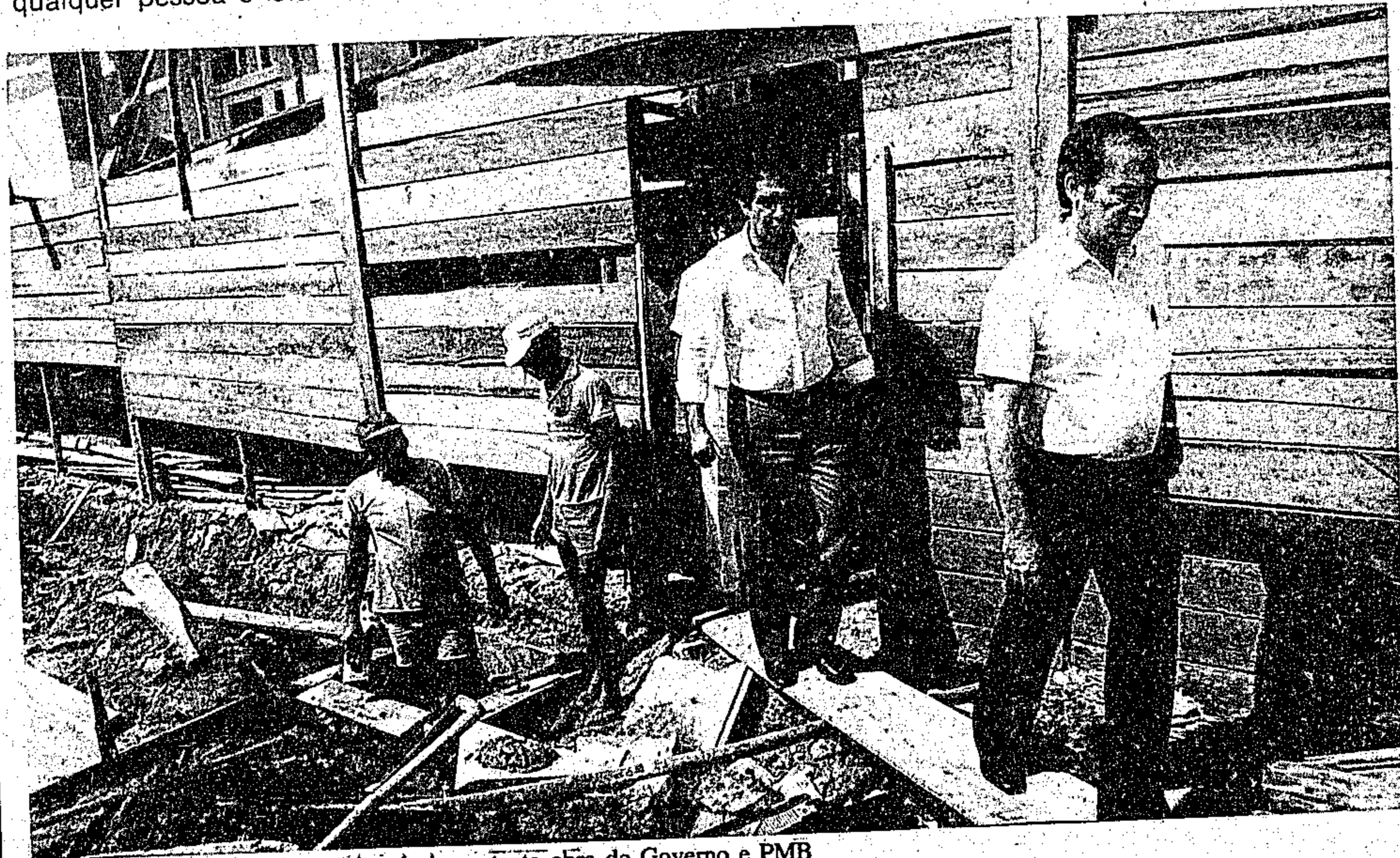
O governador visitou o canteiro da importante obra do Governo e PMB
