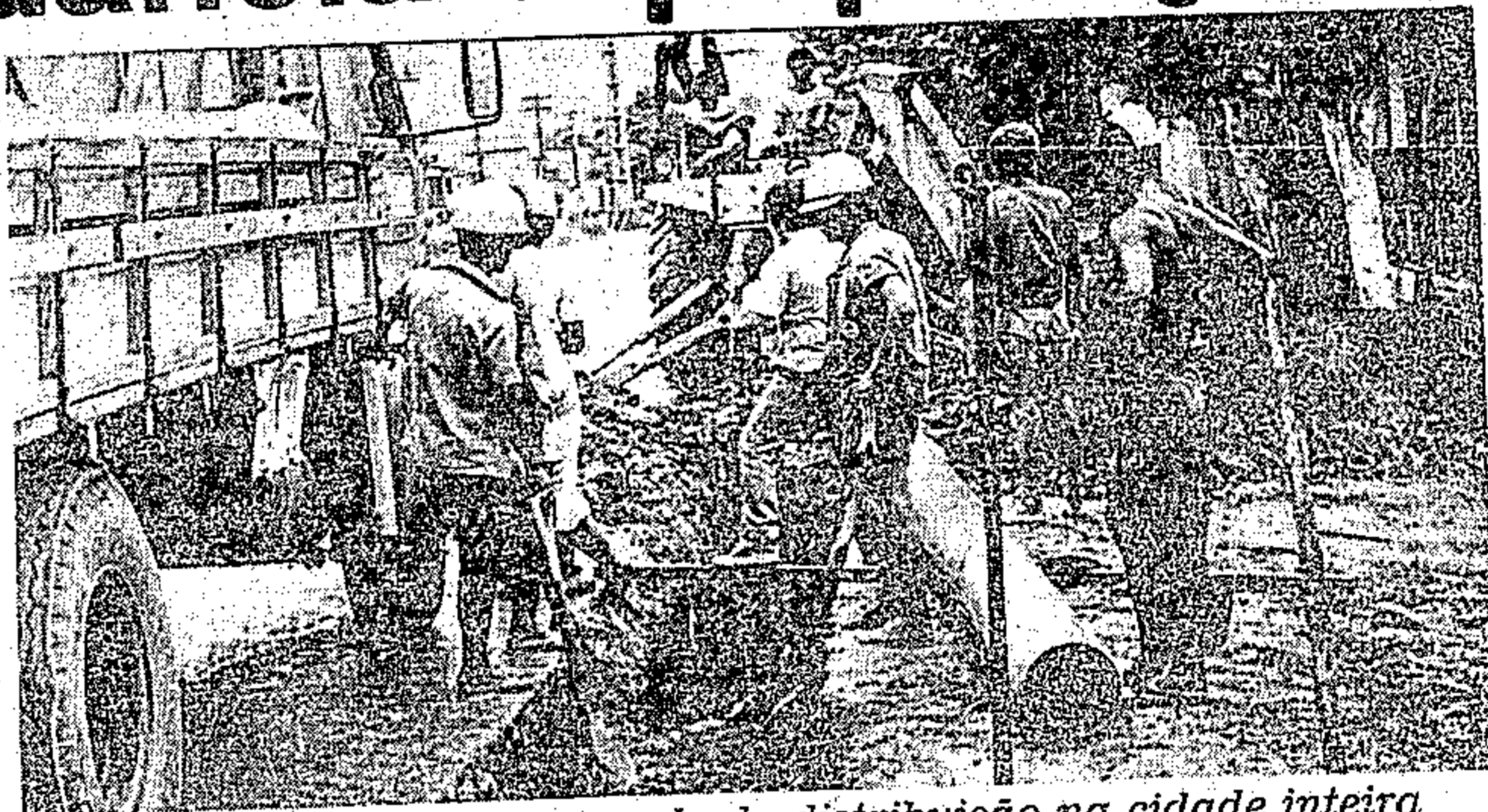
A Cosanpa implanta nova rede de distribuição na cidade inteira
